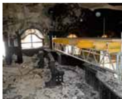
Ein Bild der Verwüstung zeigt sich noch immer auf der Empore der Kapelle.
